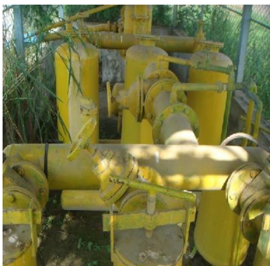
شکل ۶- ایستگاه کنترل مرکزی آبیاری قطره ای
