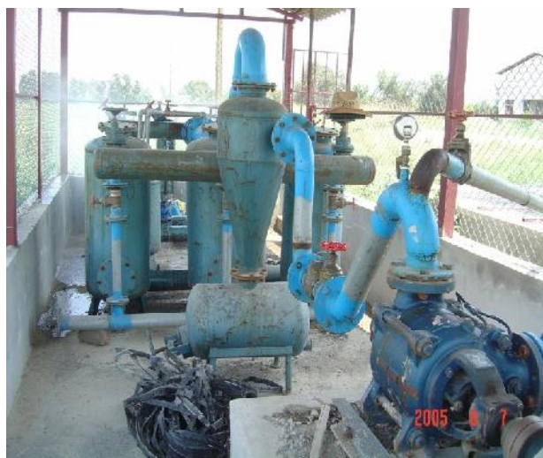
شکل ۶- ایستگاه کنترل مرکزی آبیاری قطره ای
